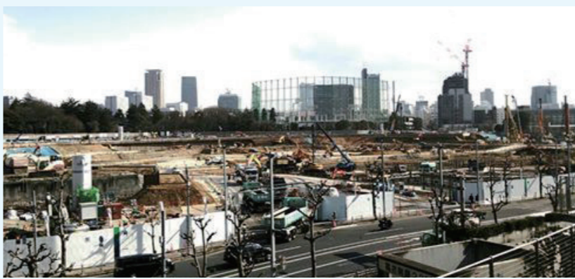
建設中の新国立競技場
